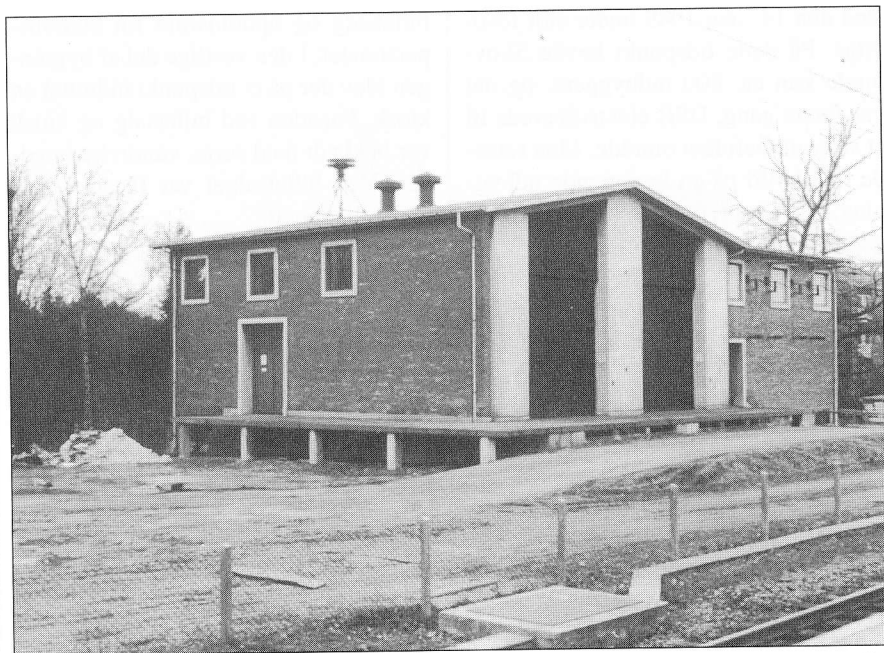
Omformerstationen ved Skovlunde Station. Foto: Strækingsregistranten, DSB bygning, 1987.
