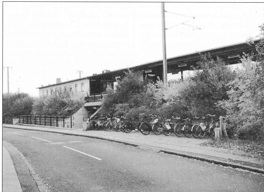
Nordsiden af stationsanlægget, hovedbygning. Foto: Strækningsregistranten, DSB bygning, 1987.
